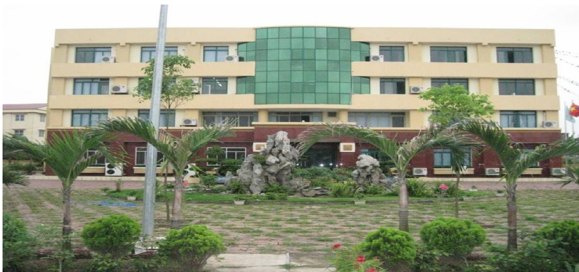
Trụ sở Công ty – Xã Tân Quang, Huyện Văn Lâm, Tỉnh Hưng Yên
